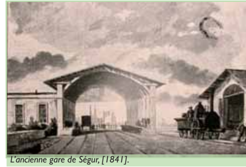
L'ancienne gare de Ségur, [1841].
