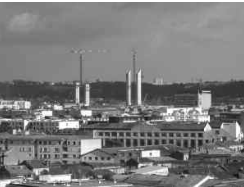
Vue sur le chantier du pont Chaban-Delmas
