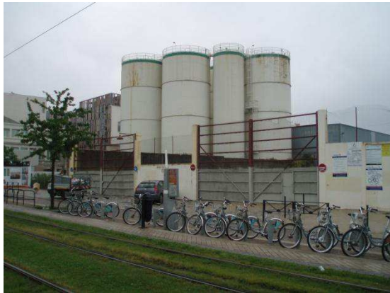
Vue extérieure du site depuis le quai de Bacalan
